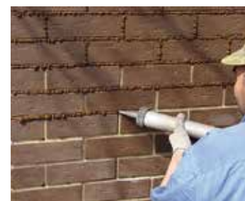
Рис. 29.2. Заполнение швов между плитками с применением затирочного пистолета
