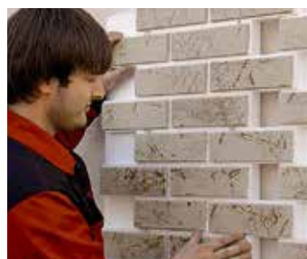
Рис. 24.1. Крепление доборного элемента термопанели
