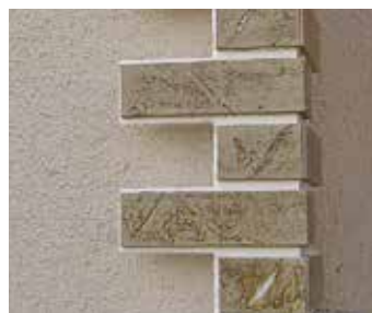
Рис. 23.1. Начало монтажа угла
