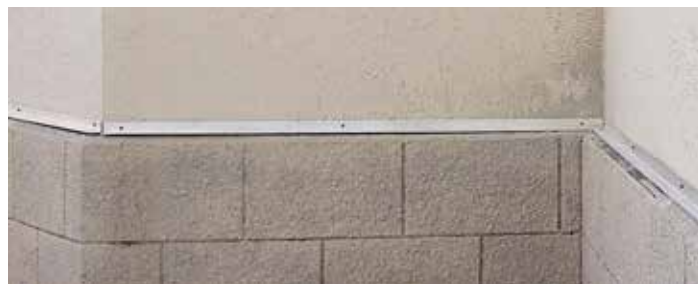
Рис. 21. Вид смонтированного стартового профиля
