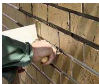
Рис. 29.1. Заполнение швов затиркой между плитками
