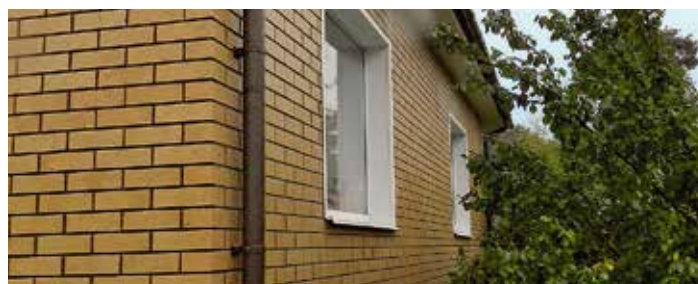
Рис. 27. Вид смонтированного водостока на фасад, облицованный термопанелями
