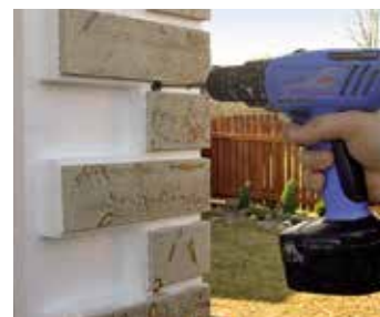
Рис. 23.2. Монтаж самореза в дюбель через втулку
