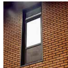
Рис. 25.2. Отделка оконных проемов
