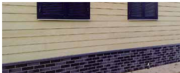
Рис. 22. Вид готового цоколя
