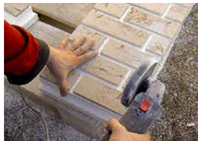
Рис. 25.1. Подрезка термопанели алмазным диском
