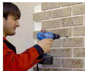
Рис. 24.2. Крепление термопанелей
